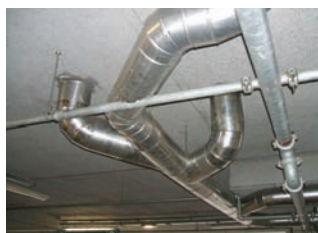
vyhřívaná vodovodní potrubí po instalaci topných kabelů
