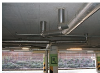
podstropní rozvody po instalaci topných kabelů
