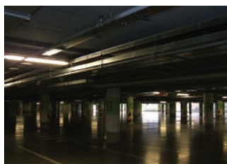
prostory s potrubím
