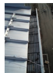
instalace topných kabelů v atypickém žlabu
