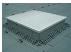
detail instalace topného kabelu okolo světlíku
