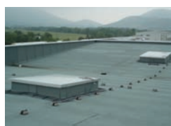
celkový pohled na střechu haly s hranatými světlíky v horské oblasti
