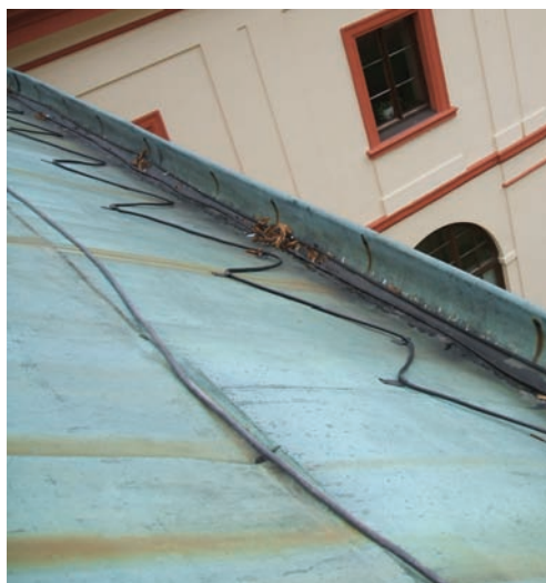
instalace topného kabelu ve žlabu a na okraje střechy
