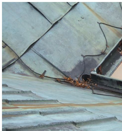
instalace kabelu u svodu
