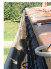
instalace kabelů na okraji střechy
