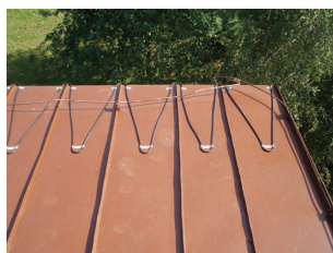
instalace topných kabelů na okrajích střechy
