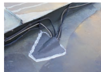
průchod přívodu napájení topných kabelů střešním pláštěm
