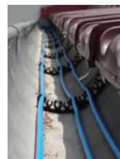
kabely uchycené ve žlabu
