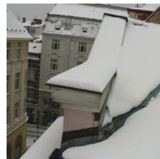
topné kabely po sepnutí systému
