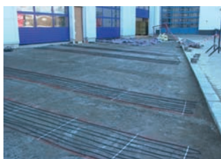
instalace topných kabelů pomocí ocelových pásek GRUFAST
