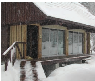
odtávání sněhu na dřevěné lávce
