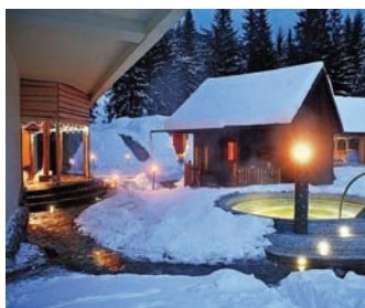
odtávání sněhu v praxi - topné kabely pod břidlicí
