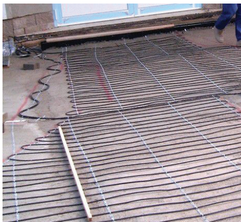
instalace topných kabelů
