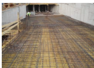
instalace topných kabelů na výztužné kari síť
