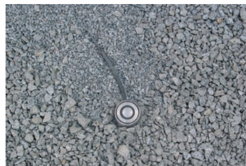
instalace vlhkostního čidla
