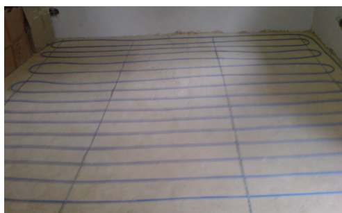
ilustrační foto z instalace topných kabelů
